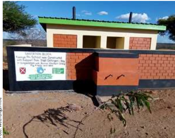
An einer Schule in Kaasya in Kenia wurden sanitäre Anlagen gebaut
